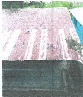
Foto 5: Sustitución de cubierta de lámina de 1 aula del módulo 2
